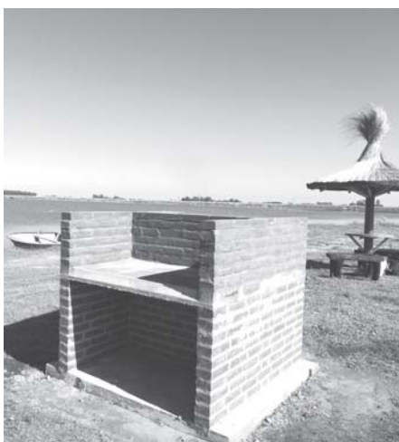
Parrillas recién construidas.
